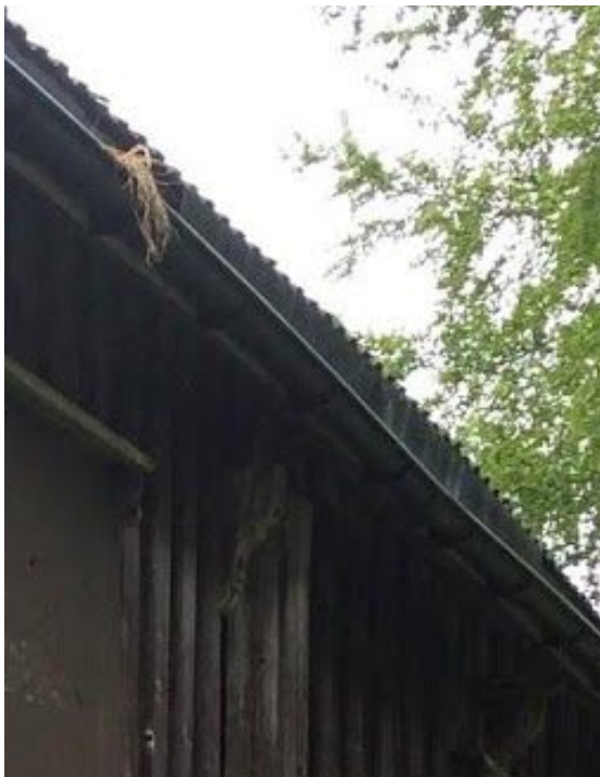
T.v: Full takrenne på sørfasade. T.h: Uheldig utforming av nedløp som tilfører grunnmur og vegg mye fukt.
