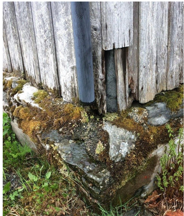
T.v: Full takrenne på sørfasade. T.h: Uheldig utforming av nedløp som tilfører grunnmur og vegg mye fukt.
