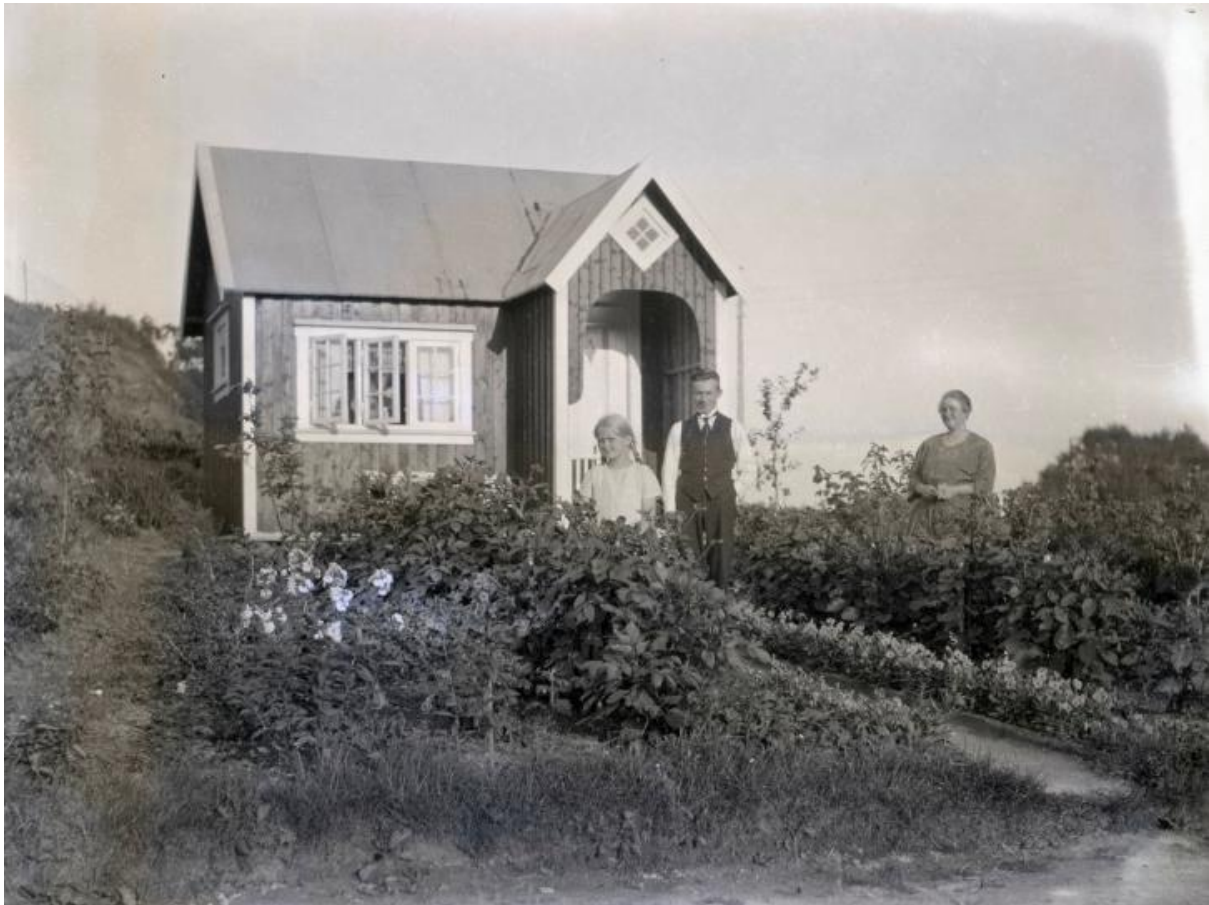
(Bilde 1 fra stavangerbilder.no . Ytterdøren med glass i bildet er fortsatt i hytta, mellom vindfang og oppholdsrom)
